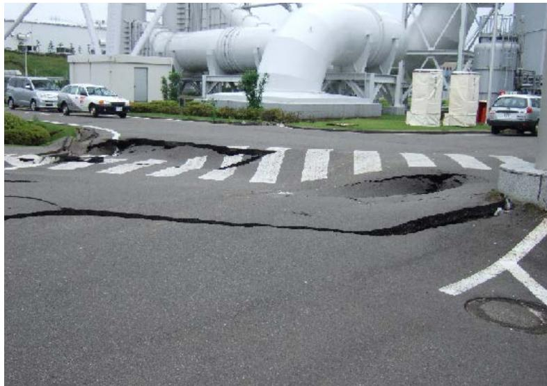
東京電力柏崎刈羽原子力発電所は、2007年7月16日に発生した中越沖地震で大きな被害を受けました。変圧器の火災で黒煙を挙げる3号機の映像は衝撃的でした。敷地内の道路は大きく波打ち、配管のずれなども生じ、放射性物質の拡散も心配されました。柏崎刈羽原発は、地震や津波などの自然災害に加え、テロなどの被害に耐えられるのでしょうか。【写真は、事故後の原発構内の様子】
